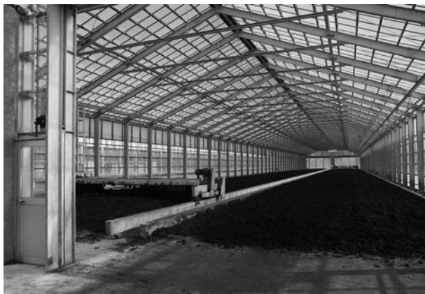
Photo. 7 受け入れた堆肥を最初に切り返して発酵を促すための施設。
