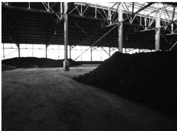
Photo. 9 ほとんど完成した堆肥を貯蔵する施設。
