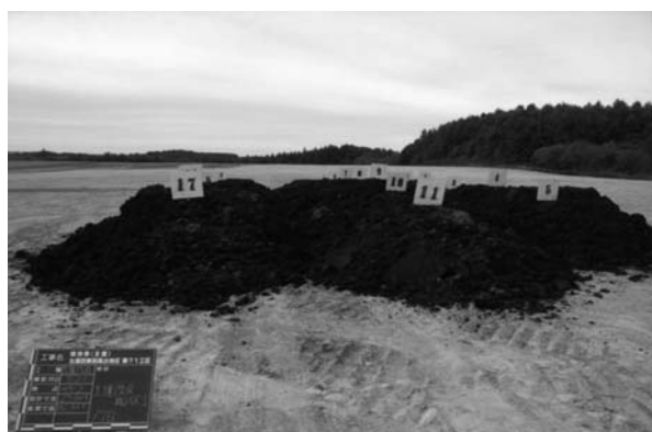
Fig. 8 土壌改良資材の堆積状況.
