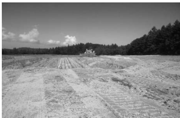
Fig. 6 ブルドーザによる放下整理.
