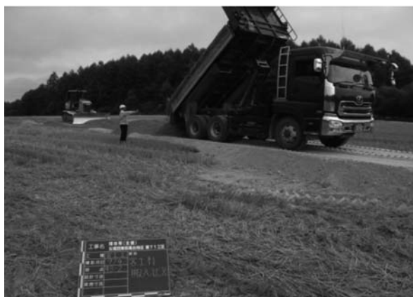
Fig. 5 ダンプトラックによる客土材の運搬.
