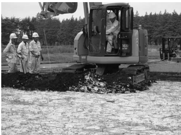
Photo 9. 油圧ショベルの排土板による集積. Accumulation by the blade of the hydraulic shovel.
