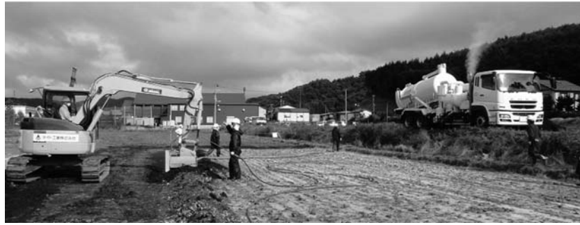
Photo. 13 ワイパー・バキューム工法. Decontamination by the wiper vacuum method.
