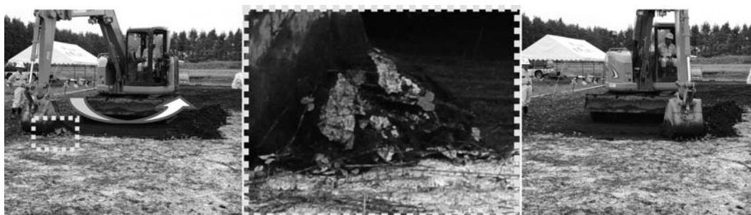
Photo. 8 ワイパー工法による剥ぎ取り状況。 View of peeling by the wiper method.
