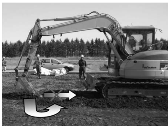
Photo. 7 油圧ショベルの掘削。 Excavation by hydraulic shovel.
