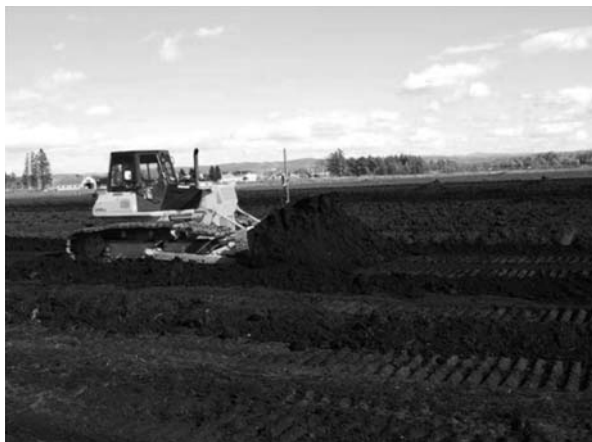
Photo. 6 レーザーブルドーザーによる運土。 Hauling soil with a laser-controlled bulldozer.
