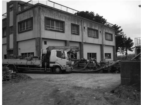
Photo. 1 被災した排水機場と災害応急ポンプ (2011.4.26).
