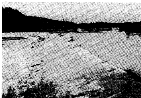
写真1 ポー河の取水堰
