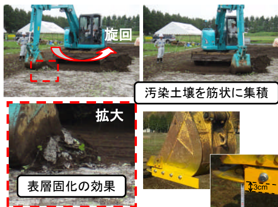
写真 2 ワイパー工法
